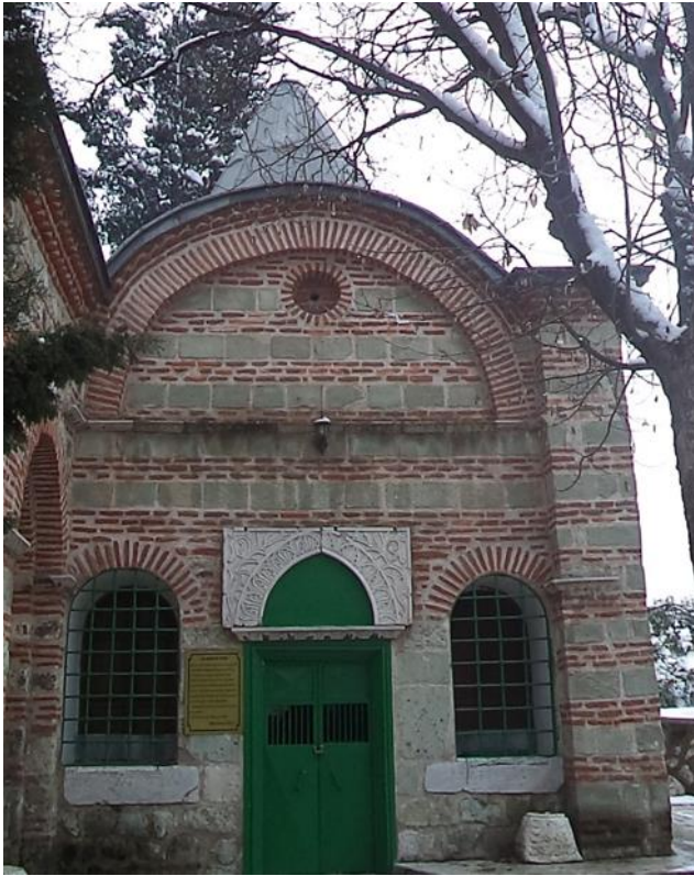
Görsel 36. Bursa, Mustafakemalpaşa Lala Şahin Paşa Türbesi, Giriş Cephesinden Kûlahın Görünümü (Ebru Yıldırım Arşivi).
