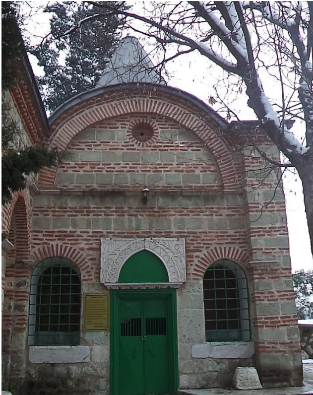
Görsel 10 Bursa, Mustafakamalpaşa Lala Şahin Paşa Türbesi, Giriş Cephesi (Ebru Yıldırım Arşivi).
