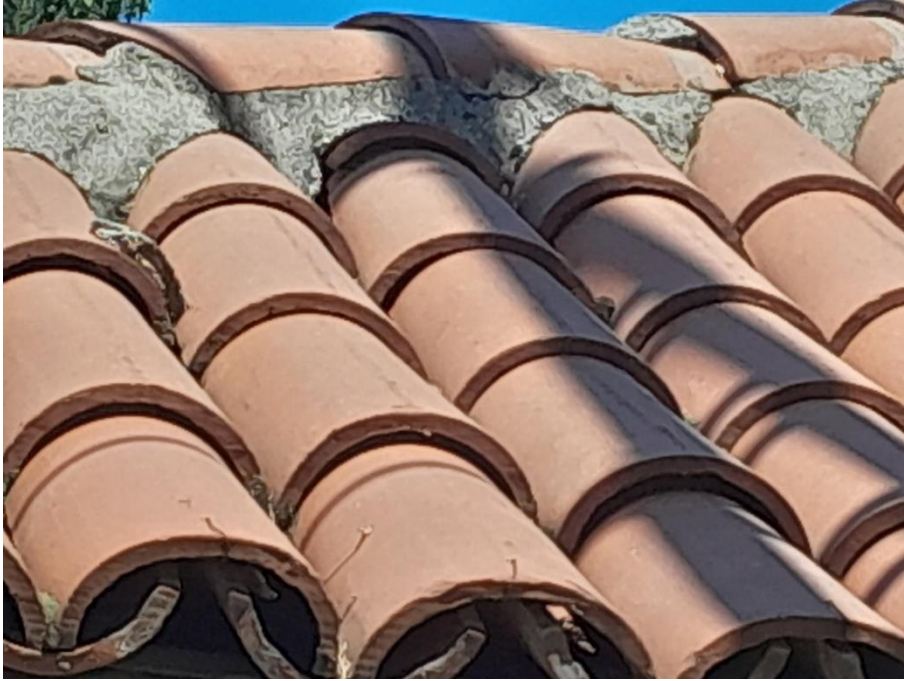
Görsel.3 :Seydi Nasır Türbesi, Çatıyı Kaplayan Kiremitlerin Yakından Görünüşü.(Ebru Yıldırım Arşivi)
