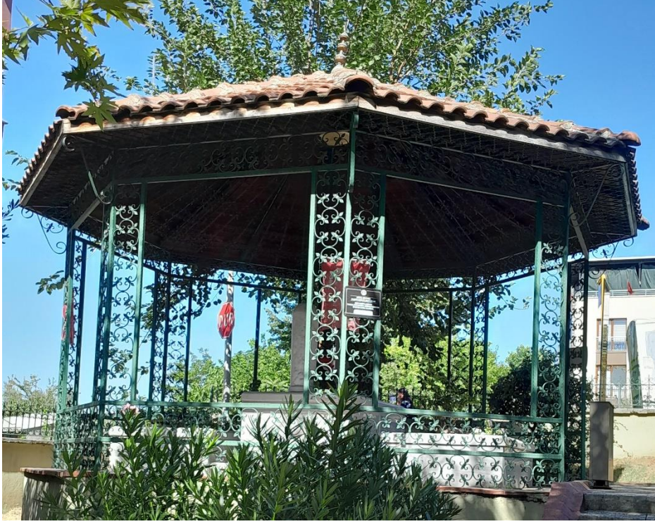
Görsel.8 Karadavut Türbesi Uzaktan Görünüm (Ebru Yıldırım Arşivi).
